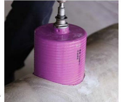
ヒューム管への穿孔の様子
