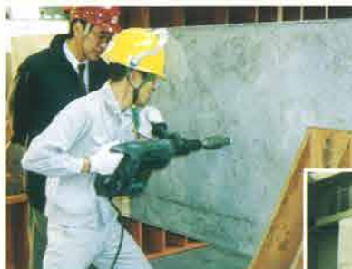
施工性確認試験 (横向き)
