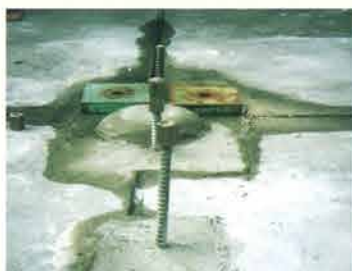
LFアンカー施工後 (グリコ乳業 (株))
