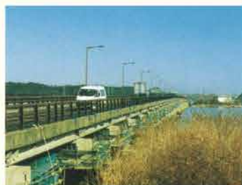
耐震補強工事全景 (神宮橋)
