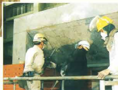
施工性確認試験 (斜め45度上向き)
